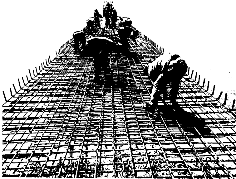
FOTO 01: Armado de acero en losa del día 01/07/19
