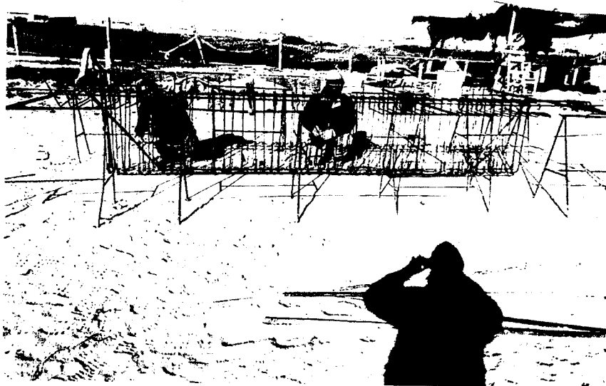
FOTO 16: Armado de viga de guardia del cabezo
