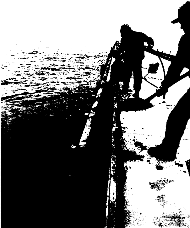
FOTO 13: Se continúa con el encofrado de sardineles
